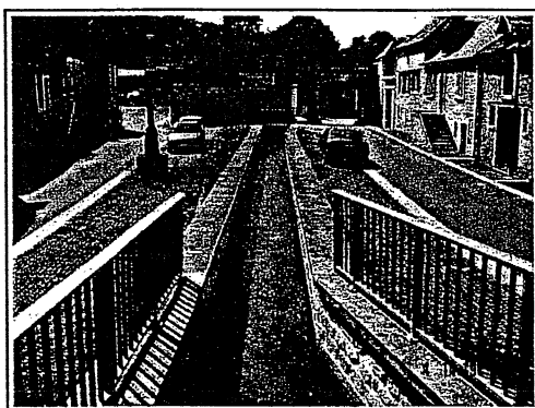
Maisons en bordure d'un ruisseau affluent à la Vesle sur la commune de Courcelles-sur-Vesle
